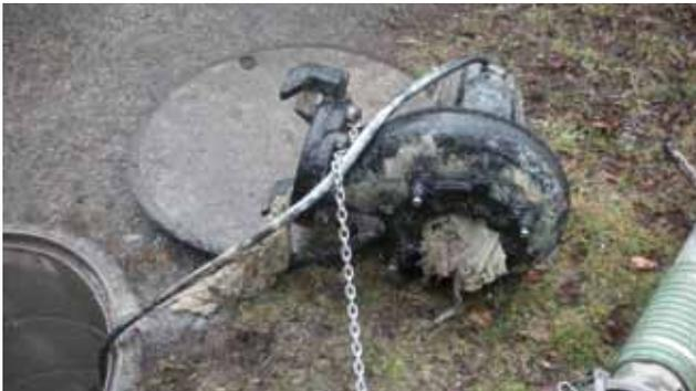
Ausgebaute, durch Textilien verstopfte Kanalpumpe (Foto: Bauhof MGO)
